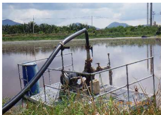
รูปที่ 2-13 เครื่องดูดตะกอนก้นบ่อ Anaerobic
