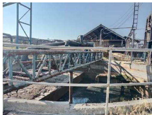
รูปที่ 2-9 บ่อพักตรวจสอบคุณภาพน้ำสำหรับดูดตะกอนก้นบ่อ Anaerobic
