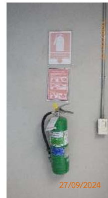
รูปที่ 2-28 จุดติดตั้งอุปกรณ์ดับเพลิง บริเวณภายในโรงงาน
